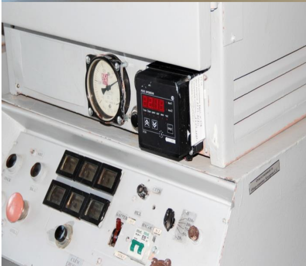
Рис. 3 Монтаж электроавтоматики для защиты камер термостатирования от перегрева в п.518,520 МИЦ – ввод в эксплуатацию лазерного комплекса FMark-50NS в МИЦ– 30,0 тыс.руб.
