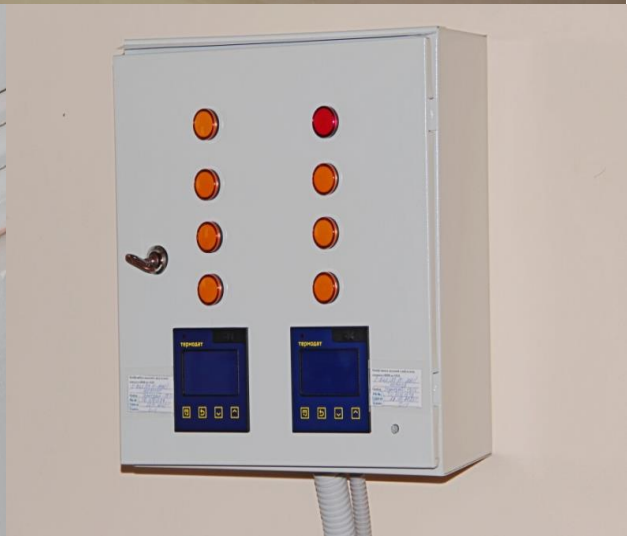
Рис. 3 Монтаж электроавтоматики для защиты камер термостатирования от перегрева в п.518,520 МИЦ – ввод в эксплуатацию лазерного комплекса FMark-50NS в МИЦ– 30,0 тыс.руб.
