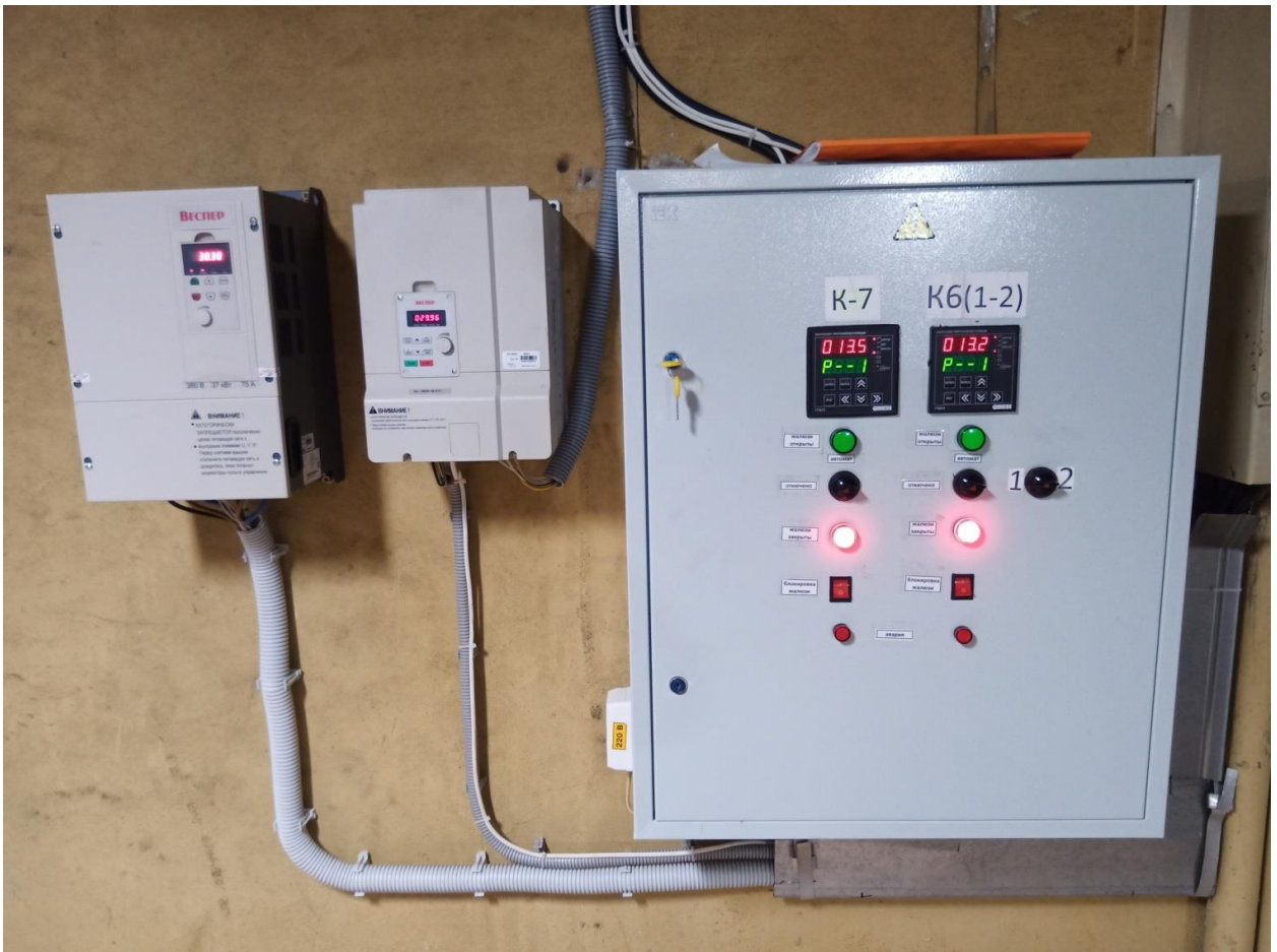
Рис. 2 Монтаж частотных преобразователей и электроавтоматики на приточных вентиляционных установках К-6 и К-7
