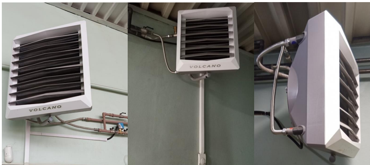
Рис. 1 Монтаж тепловых завес возле ворот в зд.100 и в ХТЛ
