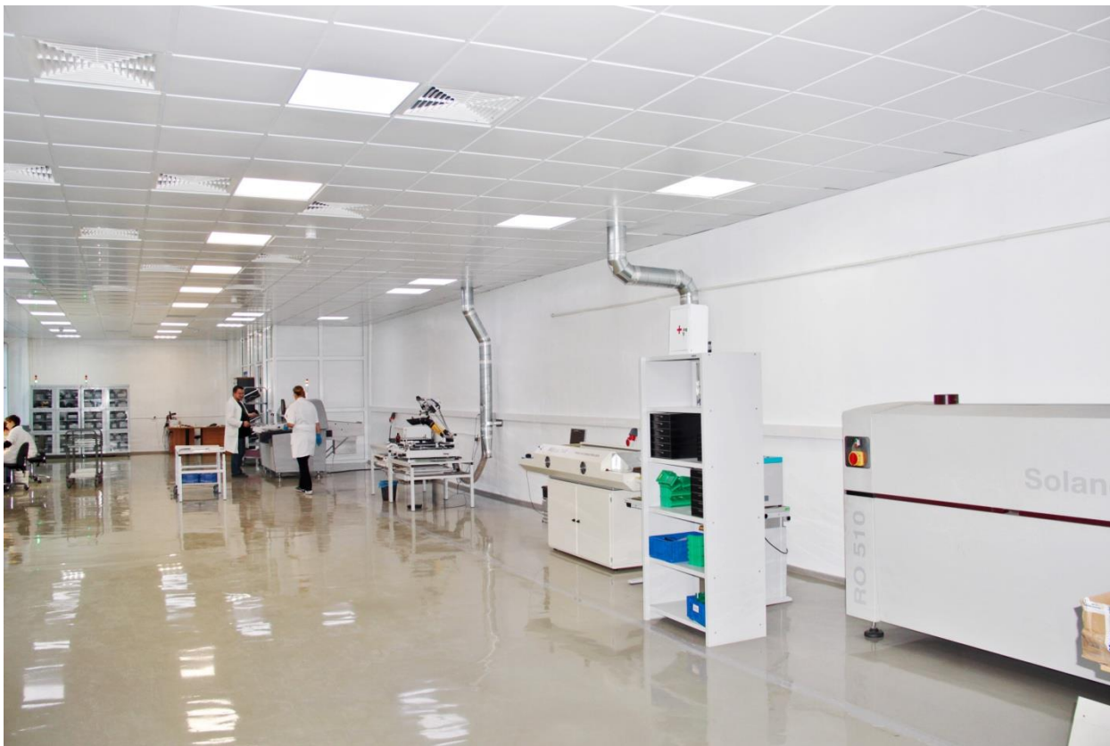
Рисунок 9: Расширение участка поверхностного монтажа МИЦ. Перемещение оборудования и подготовка инженерных сетей под новую линию поверхностного монтажа
