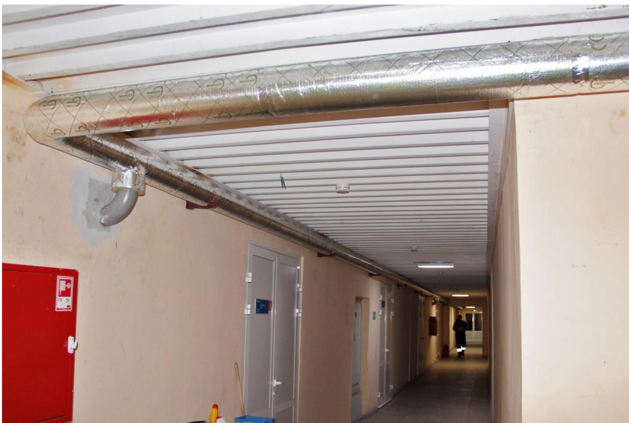
Рисунок 1: Монтаж участка водопровода ХВ 150м в зд.100
