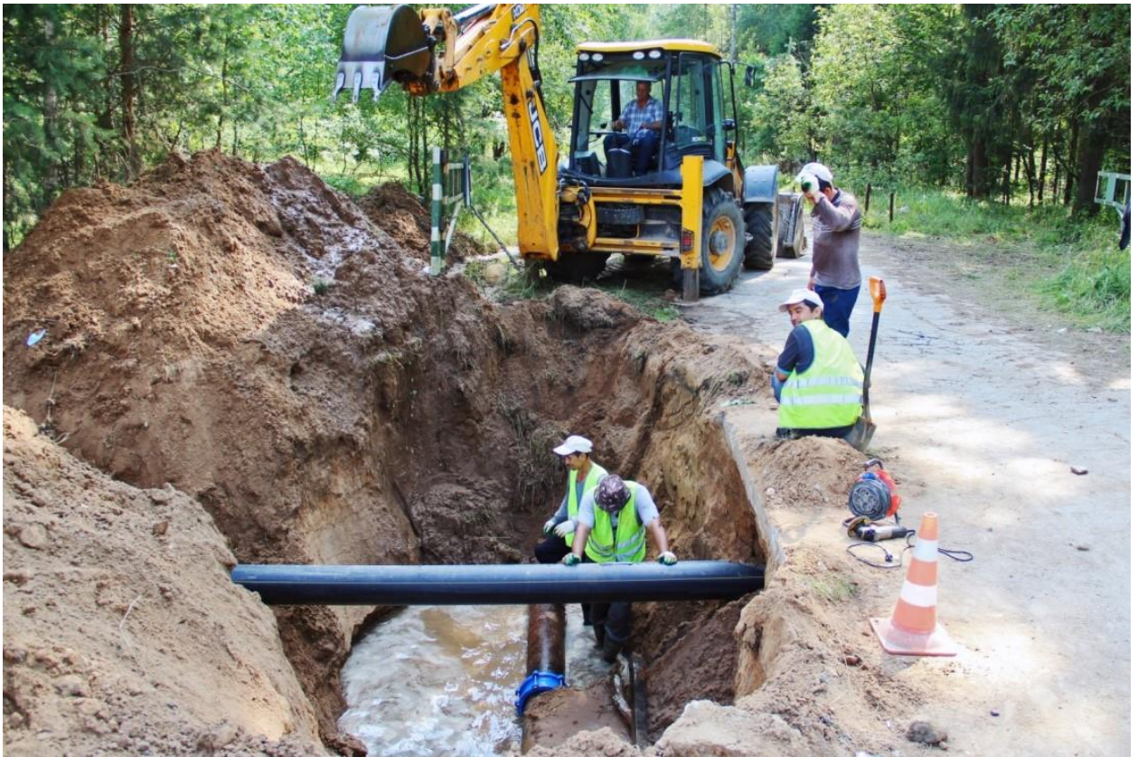
Рисунок 10: Прокладка подземного газопровода
