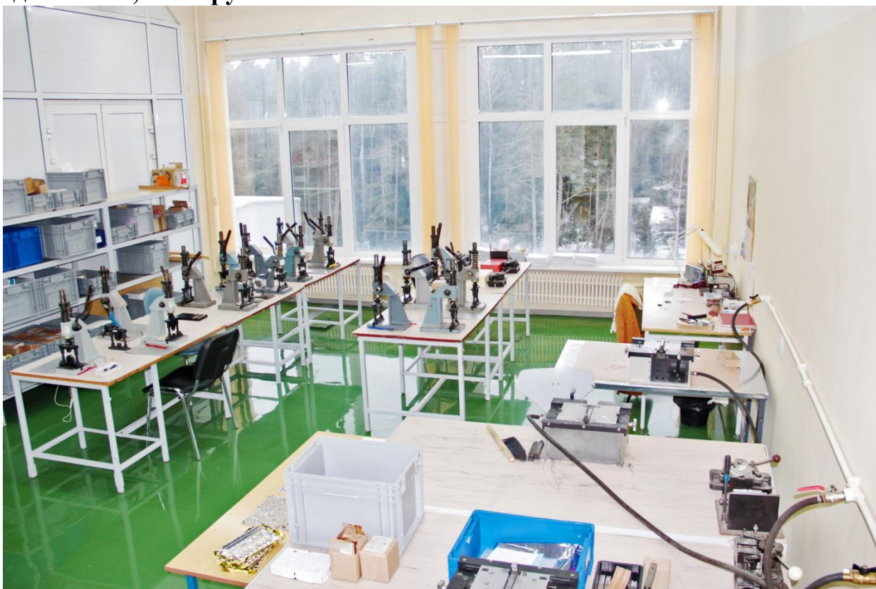
Рисунок 8: Расширение участка формовки р/э МИЦ. Ремонт пом.415, монтаж инженерных сетей и оборудования.
