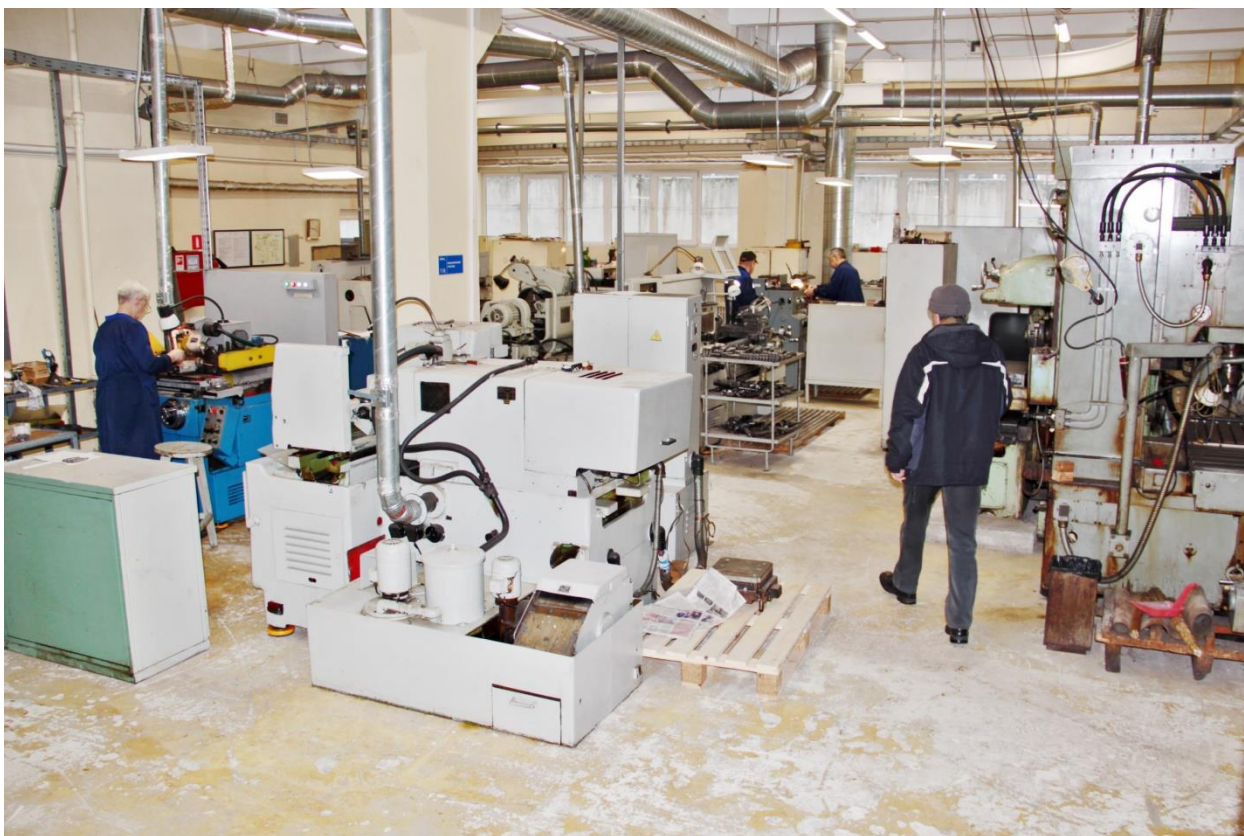
Рисунок 7: Перемещение и монтаж оборудования цеха №49 согласно новым технологическим планировкам
