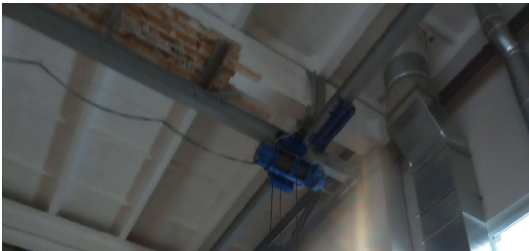
Рисунок 14. Кран мостовой однобалочный 2,0т.
